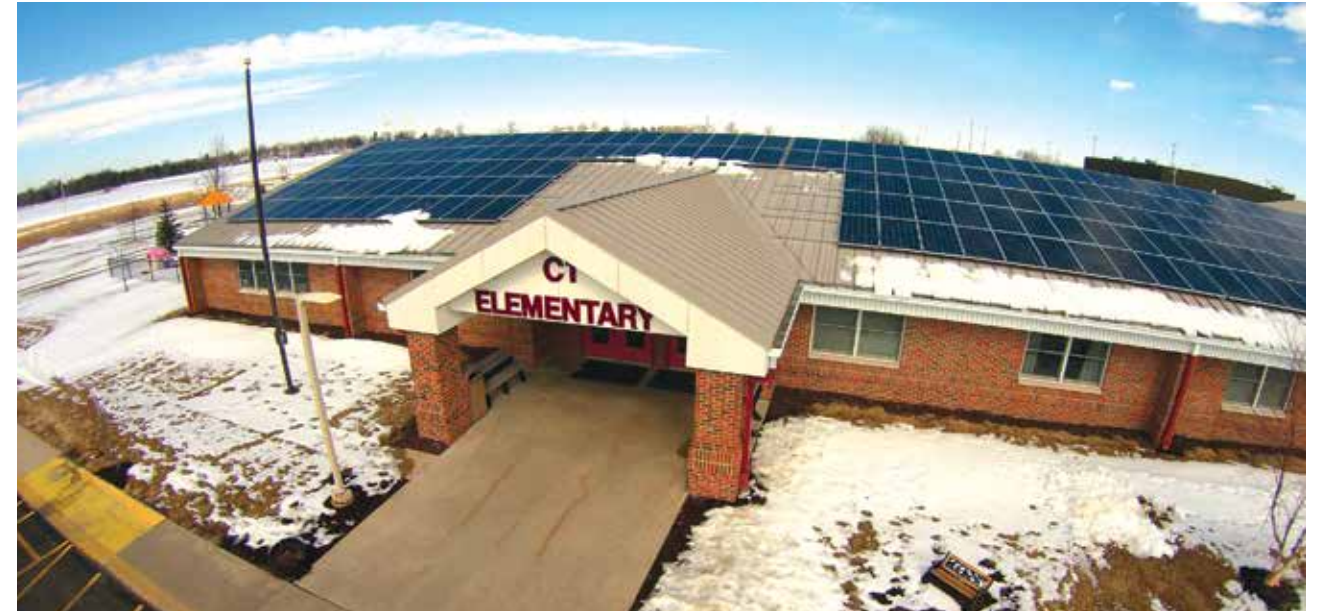
ABD, 756kW Farmington Merkez Okul Binası #265, Illinois
