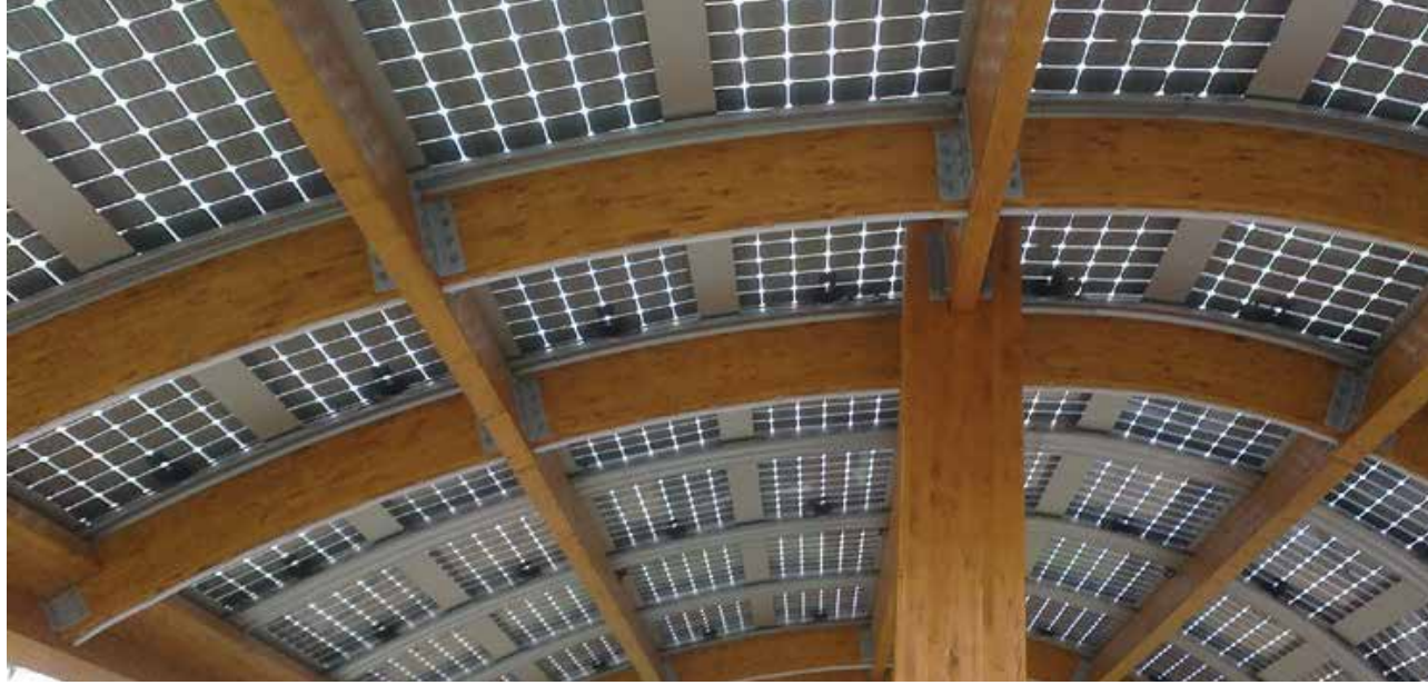
Hollanda, 3MW 39 elektrikli araç şarj istasyonu
