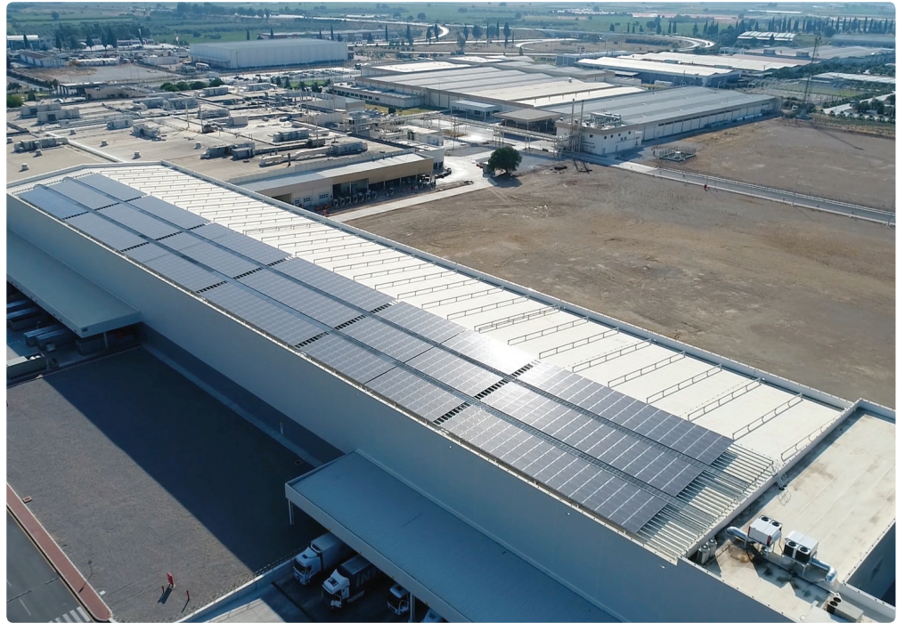
514kWp solar FV sistemi, JTİ'nin Torbalı'daki lojistik merkezinin çatısına kuruldu
