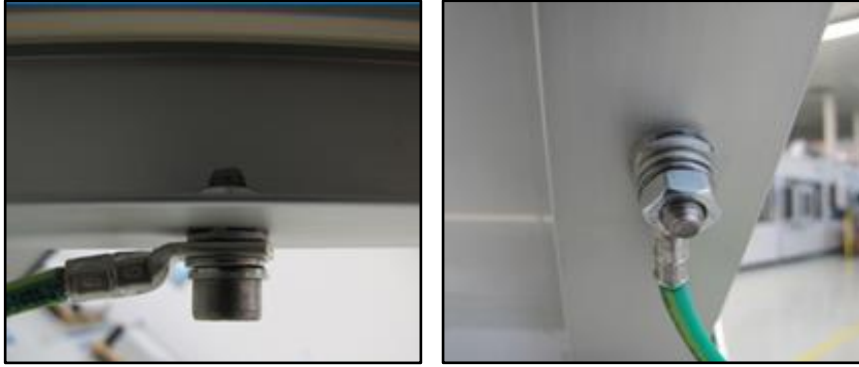
Şekil 6: Topraklama yöntemi
